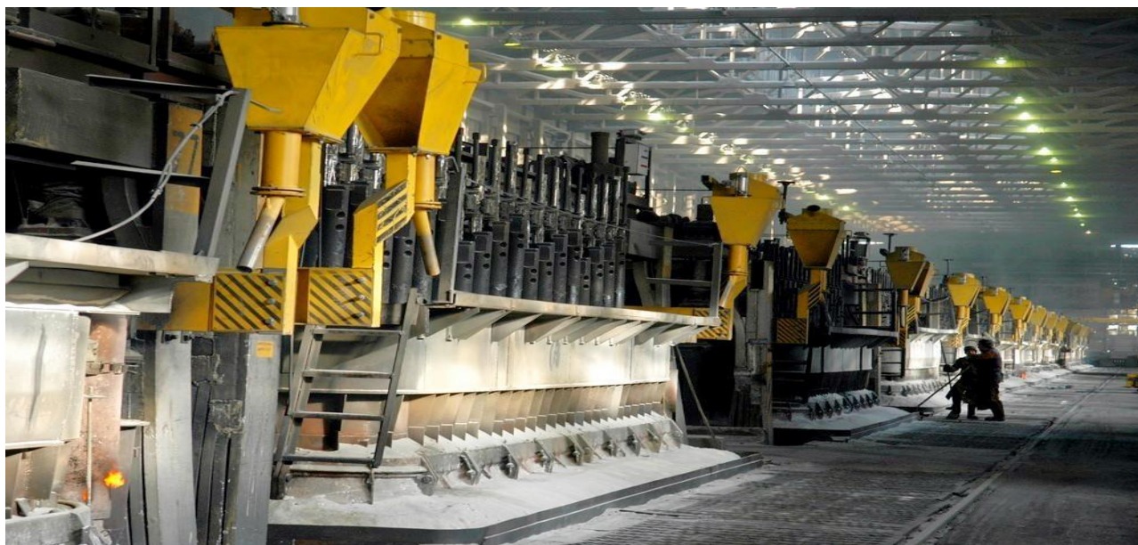
Рис. 1. Корпус электролиза с установленными ваннами типа С-8БМ
